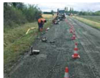
Injections de résine expansive réalisée par URETEK®
