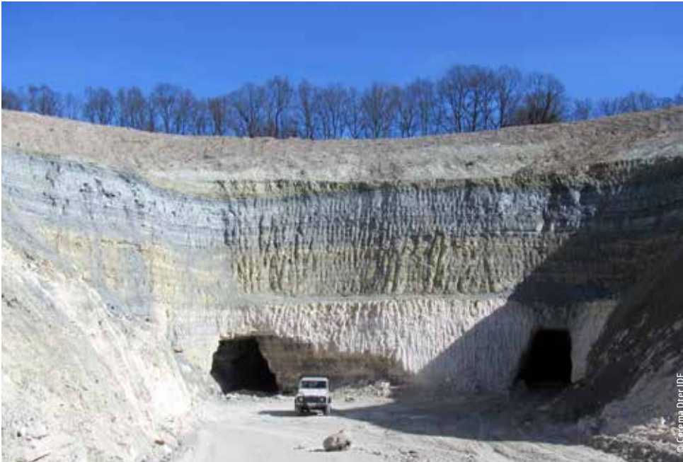
À Clichy-sous-Bois, les travaux de comblement de l'ancienne carrière de gypse appelée Fosse Maussoin sont réalisés par des moyens classiques de terrassement.
